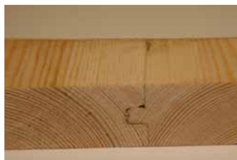
Not og fjedererformets således at det normale spillerum høvlede og pløjede brædder har på bagsiden ikke findes. Derved er udvendig og indvendig ladside uden not.
