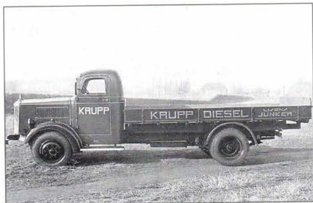
Reklamebil for Krupp Diesel. Måske den største af typerne. Dansk bygget førerhus og lad, og noget så engelsk som parkeringslygter på forskærmene. Men hvorfor udfyldte man ikke rummet mellem kofanger og forskærm - en rigtig cyklistfanger.
