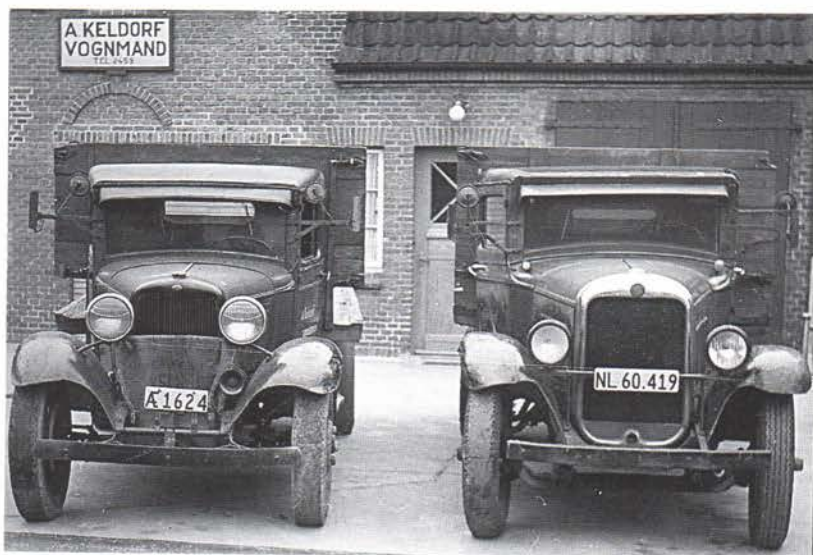
Fordson 1932 og GMC 1931 foran Keldorfs garager. På Fordson ses udskæringer i begge sider af forsækkelen for transport af langt gods. Begge vogne havde sidespejle, som kan svinges op. GMC havde støbte jernhjul med aftagelige fælge. Bemærk dekmønstrene.
