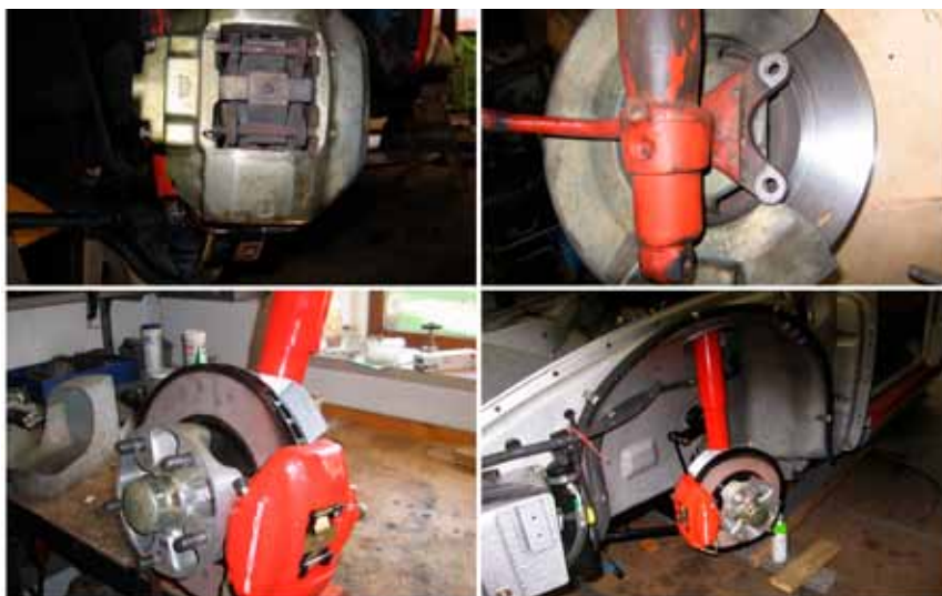
Der er tidligere eftermonteret ekstra kraftige bremsecalipere. Alt adskilles, pakninger udskiftes og der monteres nye støddæmpere både for og bag. Hele forhjulsophænget færdigmonteres på arbejdsbordet, så det er klar til montering. Forhjulsophæng monteret, ny accumulator til airconditionanlægget, nye slanger, fittings og nyfremstillede rustfrie slangeholdere.
