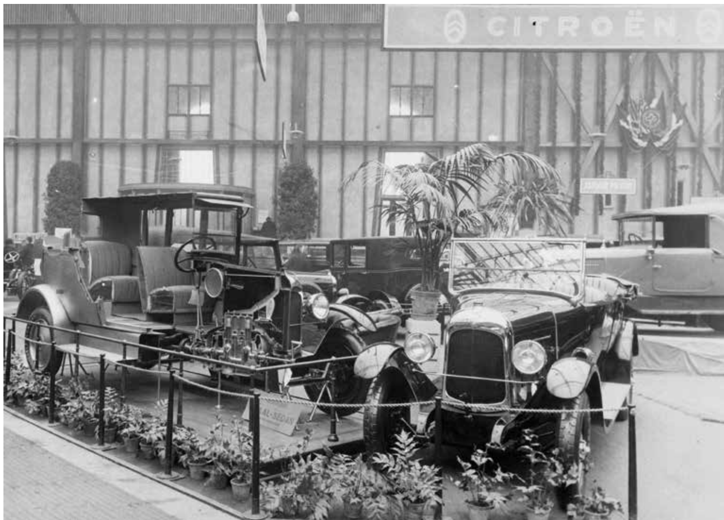
Da B10 med helstålskarrosseri blev præsenteret på Parisersalonen i oktober 1924 viste man denne gennemskårne "Staal-Sedan", som var fremstillet hos Budd. Her er den på besøg i København, biludstillingen i Forum 1926. Den åbne vogn til højre er faktisk modellens efterfølger B12, som kan kendes på den længere chassisramme, med de halvelliptiske forfjedre.
