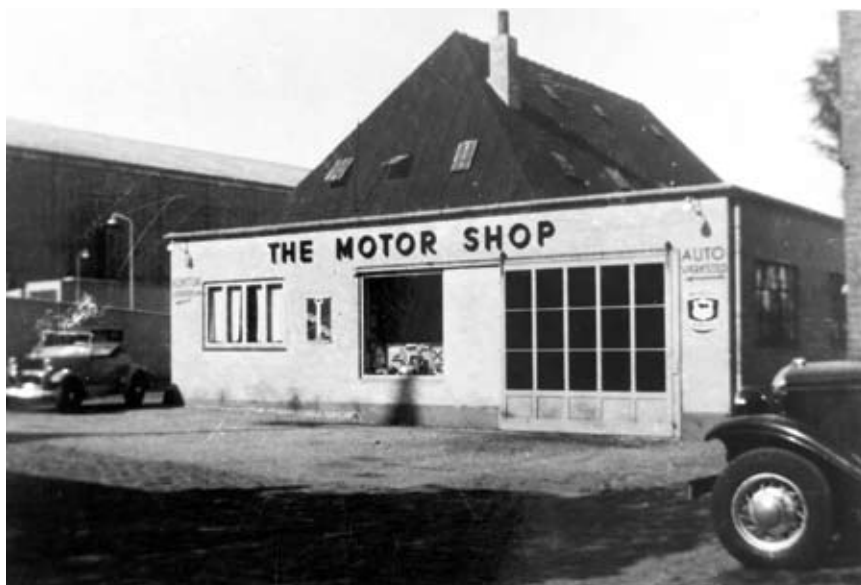
Værkstedsbygningen i Strandgade set udefra. Bag porten fandtes vaske- og smørehal. Foto fra 1936.
