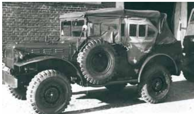
Dodge WC56 eller WC57 Command Car USA, hvis den har spil. Det fremgår ikke af foto, der er beskåret. Denne vogn har et 5 personers karrosseri, blafredøre og let kaleche, ellers samme chassis og mekanik som Foto F. En letkøret og i dag særdeles efterspurgt og kostbar vogn.
