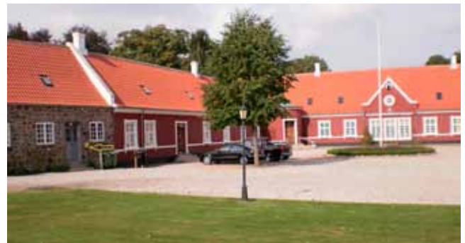
Ristrup Hovedgård, mødelokalet er der ved den gule pil tv. I billedet.
