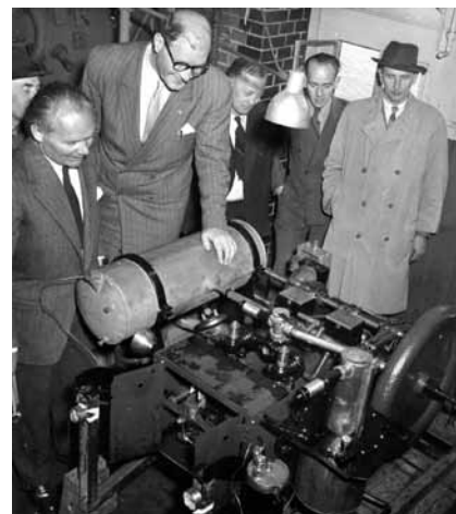
Hammelvognens motor beundres efter restaureringen i 1952.
