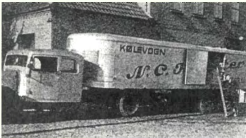
M.A.N.-dieselvogn med sættevogn. Kølemaskinen ligger i den forreste ende af kassen bagved jalousiet. Vognen holder ved den tyske grænse til tolleftersyn.
