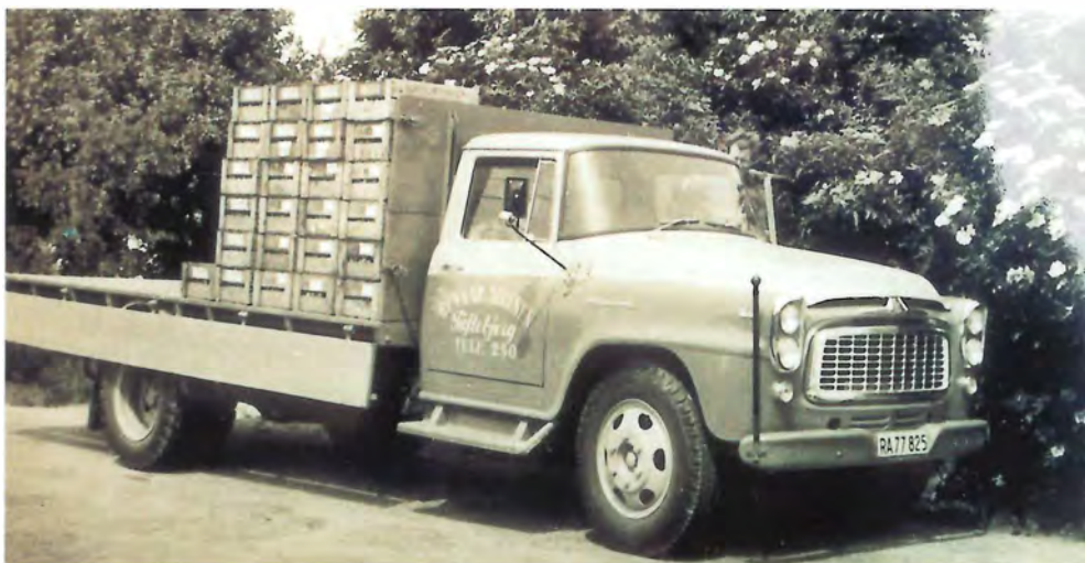
B model 164 var udstyret med en D301 dieselmotor og var med traditionel kølerhjelme.
