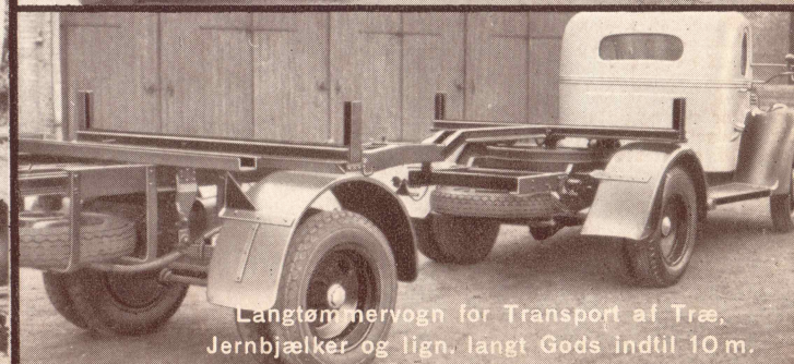
Special Sættevogn med hydraulisk Tippetad tilkoblet 134" Chassis.
