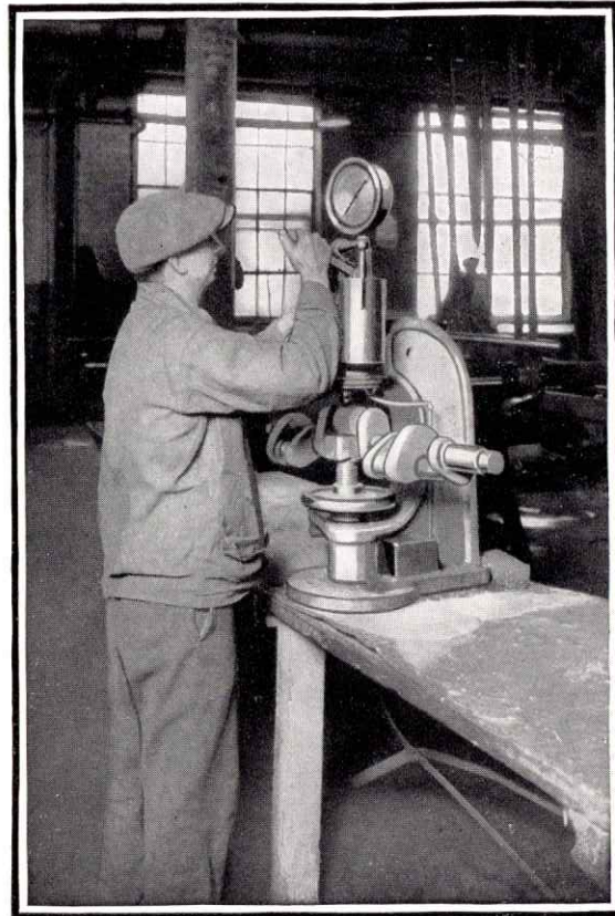
Brinnell-Prøven angiver Staalets Haardhed med absolut Nøjagtighed. En lille Staalkugle bliver under stærkt Tryk presset mod den Del, som skal prøves. Diameteren af det Mærke Kuglen efterlader i Materialet angiver Haardheden. For stort Mærke — for blødt Materiale. For lille Mærke — for sprødt Materiale. I begge Tilfælde bliver Delen kasseret.
