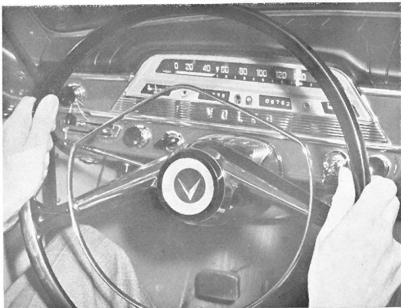
Speedometeret er af rulletypen og giver ikke mulighed for fuld så nøjagtig aflæsning som en tynd urviser på en rund skive.
