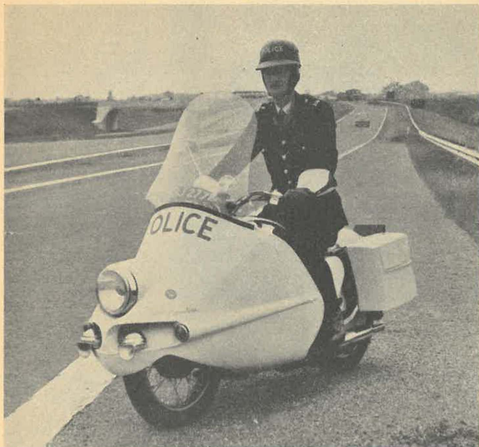
Der er endnu ikke så mange kilometer motorvej i England, men det engelske politi har rustet sig til de særlige krav, som hurtig kørsel på disse strækninger kræver. Her er en indkapslet Golden Flash, der vinder ca. 10 km/t i top-hastighed på grund af strømlinebeklædningen.
