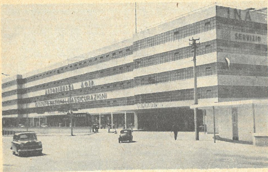
Det store garagekompleks i Venedig. Her afleverer man sin vogn på samme måde, som man afleverer sit overtøj i en garderobe. Der er ialt plads til 2000 biler i 6 etager. Benzinpumperne findes på en rampe foran bygningen, men luft kan man kun få på etagerne. Garagelejen er kr. 3,50 pr. dag.
