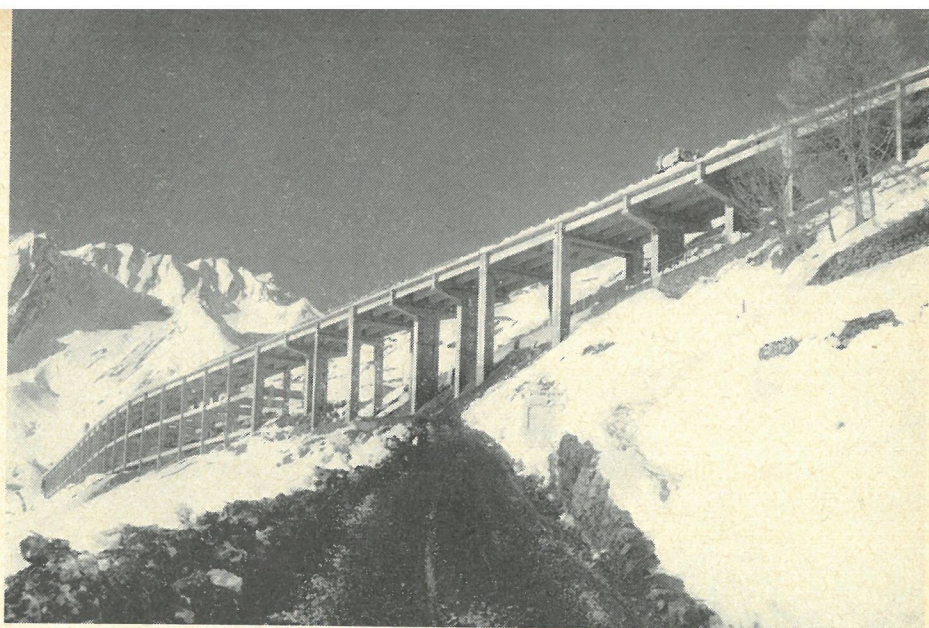
På begge sider udføres der kostbare vejanlæg, der for en stor del overbygges således, at sne ikke kan blokere kørebanen. Her ses viadukten ved Ronc på den italienske side.
