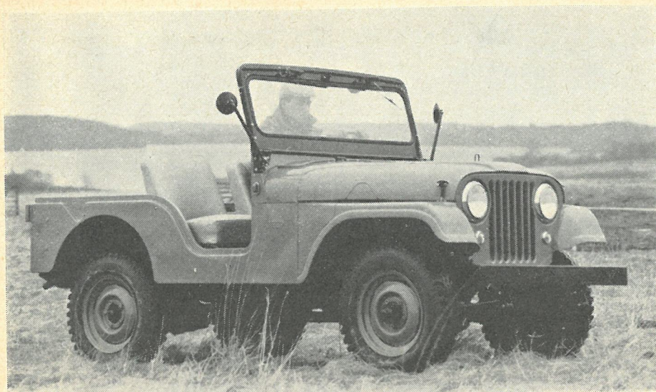
CJ-5 Jeep ligner sin forgænger, blot har den lidt mere afrundede former. Da der uvægerligt kan opstå forviklinger, hvor en indregistreret Jeep benyttes som traktor og til stationær drift på grund af afgiftsfri traktorbenzin, vil udgaven med dieselmotor sikkert være en løsning.
