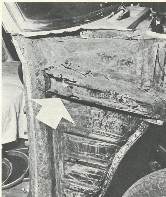
Dette skulle være en lukket, bærende kasserammeprofil, men det er en temmelig åben, ikke bærende rustskal. En udbredning lader sig i dette tilfælde forholdsvis let udføre, men i andre tilfælde kan sagen enten være umulig eller i bedste tilfælde temmelig kostbar.
