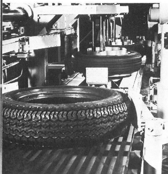
I en helautomatisk balanceringsmaskine kontrolleres de færdige dæk og får påført en rød farveklat på dæksiden ud for dækkets letteste punkt. Ved montering på fælg sørger man siden for at placere ventilen her.
