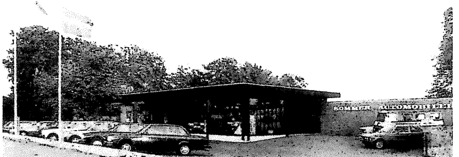
På Kongevejen i Helsingør blev der i 1965 etableret et stort anlæg hvor det eneste synlige var udstilling og kontor. Værkstederne og reservedelslager ligger skjult for øjet.
