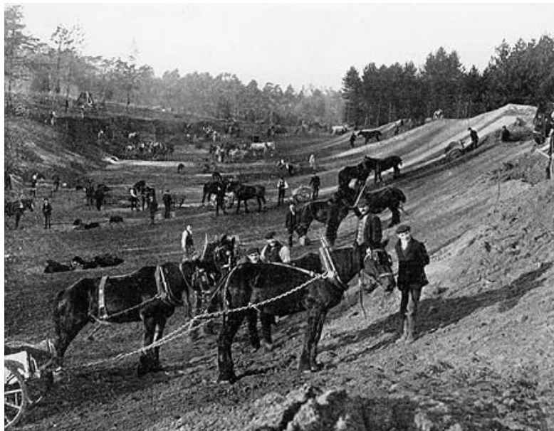
Banen under anlæg i 1906
